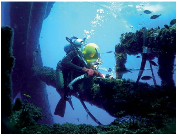
Unterwasser-Schweißer bei Reparaturarbeiten
