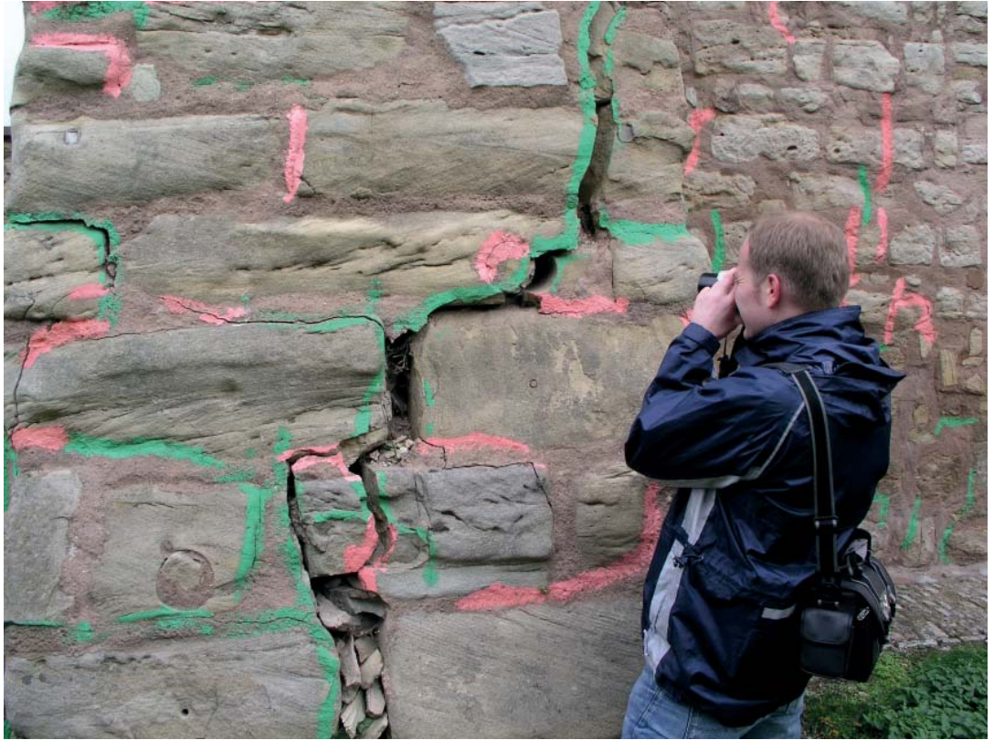
Jan Hebig bei der Aufnahme von Schäden an Baudenkmalen
