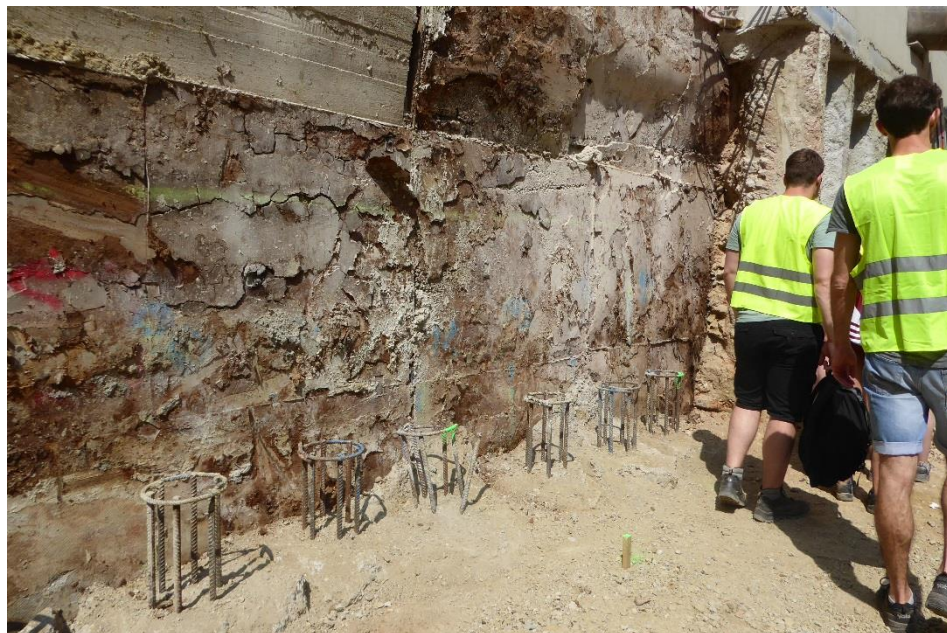
Lückenbebauung STRABAG-Baustelle Gumpendorfer Straße
