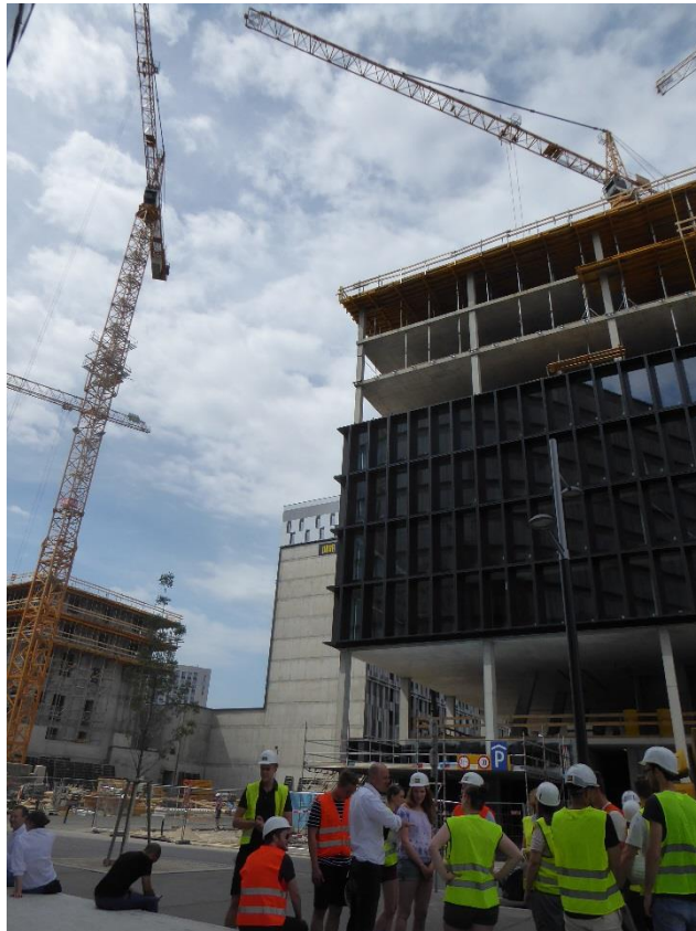
Baustellenbesuch PORR „Quartier Belvedere Central“
