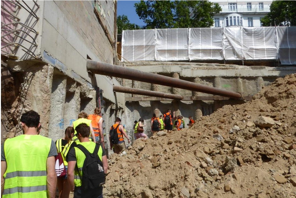
Lückenbebauung STRABAG-Baustelle Gumpendorfer Straße
