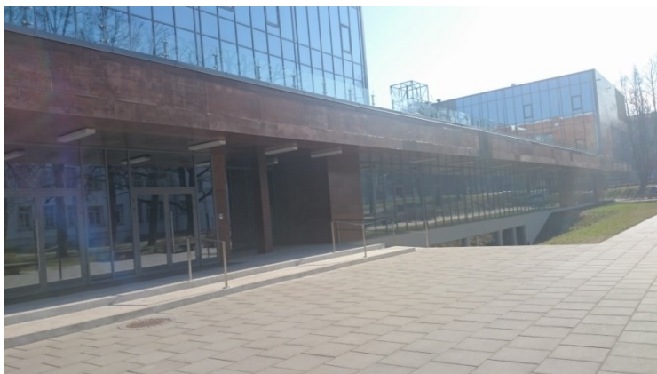
Ingenieurgebäude der RTA
